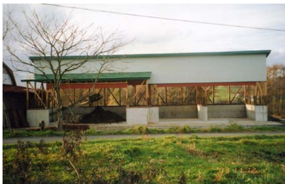
写真 32：整備された堆肥処理施設
