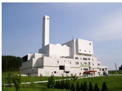
写真 10 : 滝沢村清掃センター
