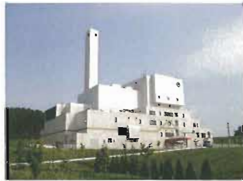
写真 10：滝沢村清掃センター
