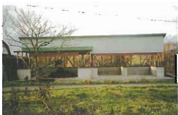
写真 32：整備された堆肥処理施設
