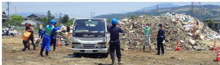
作業員の配置
