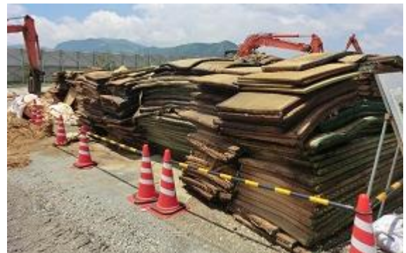
畳は積み上げ高さを2m以下とする。
