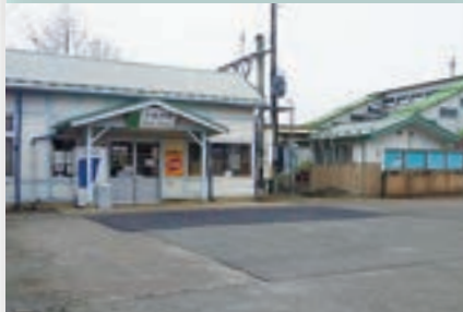
小岩井駅前広場の舗装工事など 7,650万円
