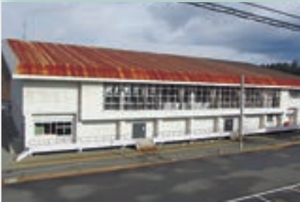
東部体育館の屋根やトイレの改修 1億2,267万円
