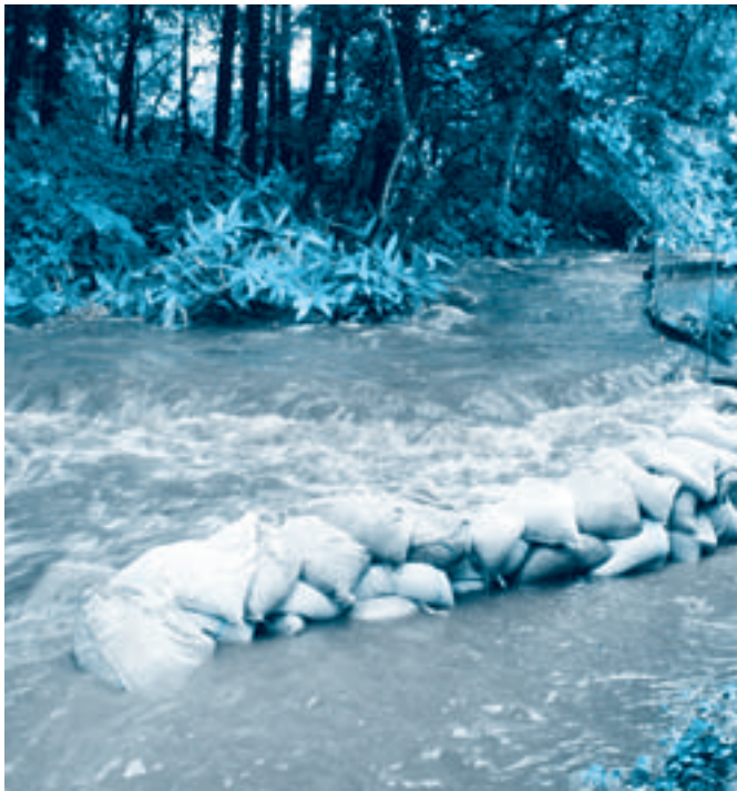
▲大雨で越流した越前堰 (H17.8.15)
