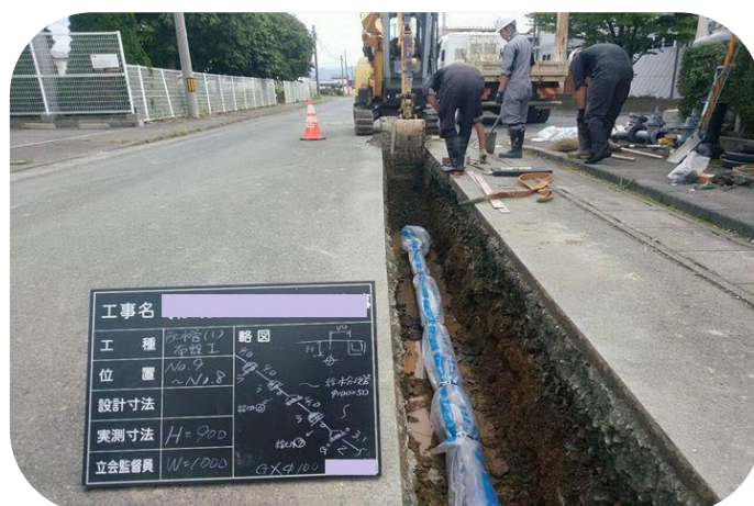
地震に強い耐震管に順次更新していきます
