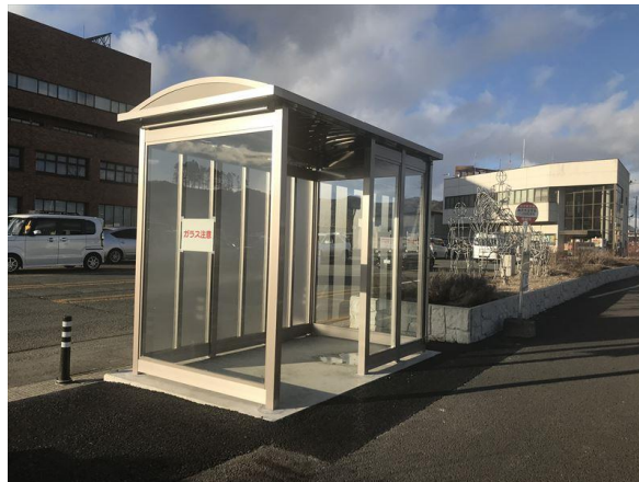
▲ 2番のりば（滝沢市役所前（道路沿い）） 今年度ボックスシェルターを整備 今後デザイン等施工予定
