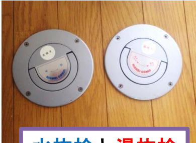
水抜き栓と湯抜き栓 (床付タイプ)
