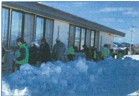
屋根からの落雪で埋まったコミセン裏の排気口を確保
