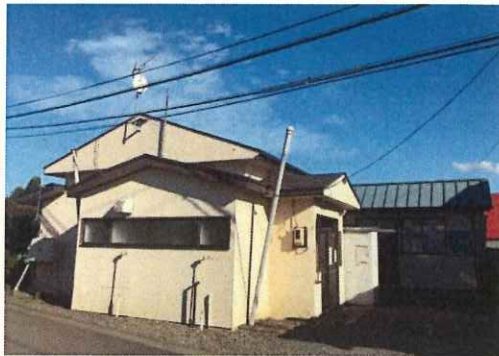
小岩井自治公民館。昭和38年に竣工し、地域の中心 的集会施設として親しまれ活用されてきました
