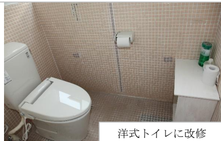
滝沢市役所の工事終了検査
