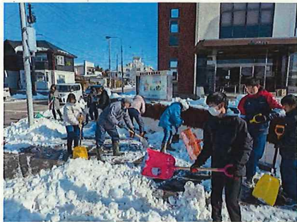
交差点に積み上げられた雪を除雪
