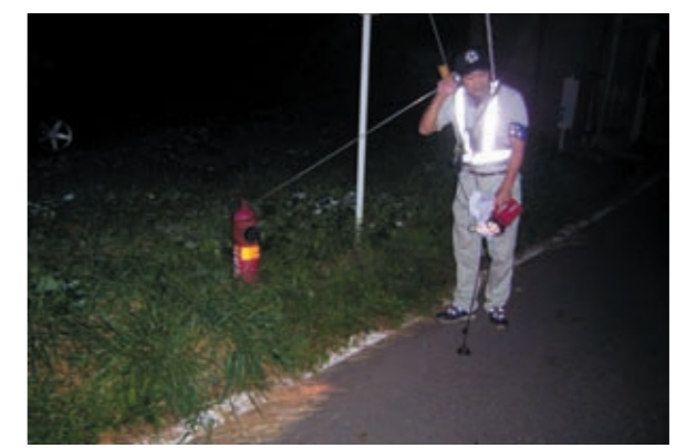
漏水箇所を調べるため、深夜に行われる配管路の音聴調査
