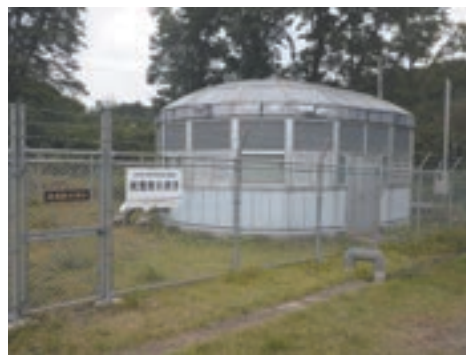
↑ 姥屋敷水源の建屋
