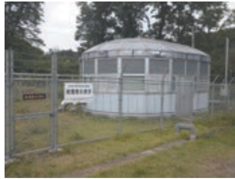
↑ 姥屋敷水源の建屋
