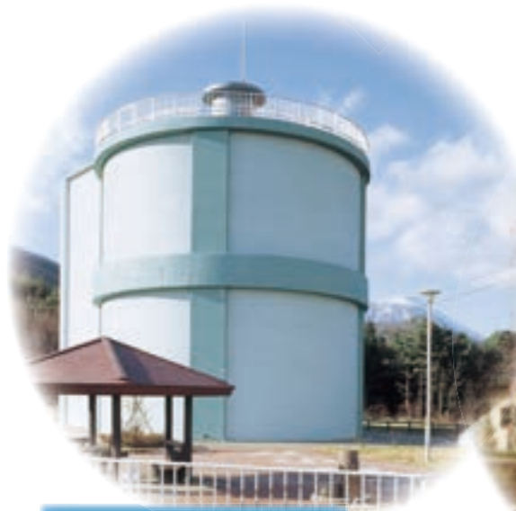
湯舟沢配水池
