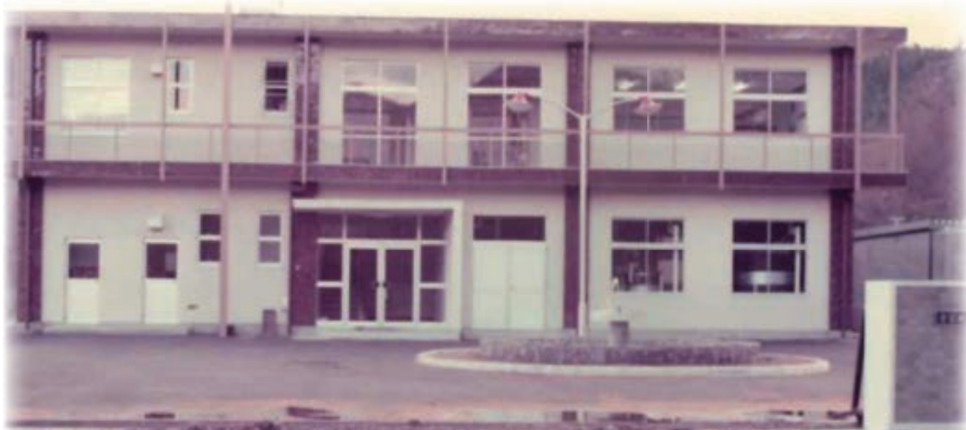
建設当時の滝沢浄水場(昭和50年)
