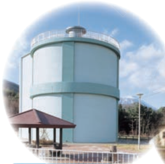
湯舟沢配水池
