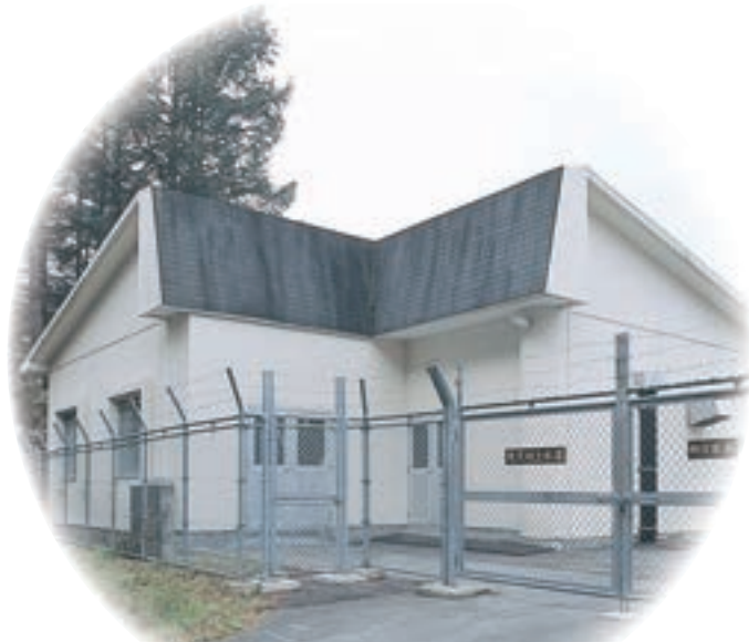
柳沢取水ポンプ場
