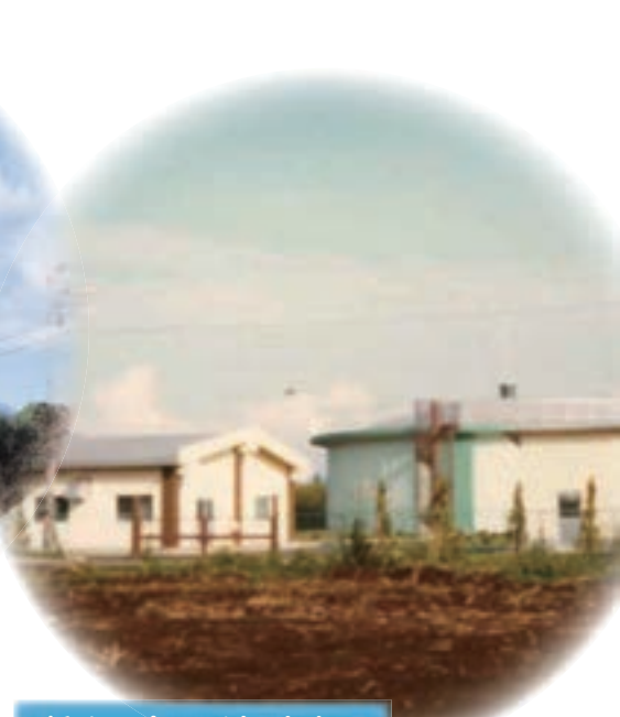
柳沢高区浄水場
