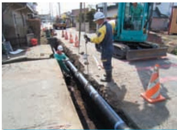
水道管の耐震化を進めています
