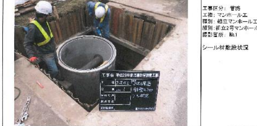
工事区分：管路 工種：マンホール工 種別：縦立マンホール工 種別：縦立マンホール工 撮影箇所：M6
