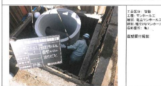
工事区分：管路 工種：マンホール工 種別：縦立マンホール工 種別：縦立マンホール工 撮影箇所：M6
