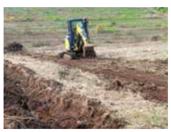
▲栽培面積の拡張のため、荒地を開墾する作業の様子
