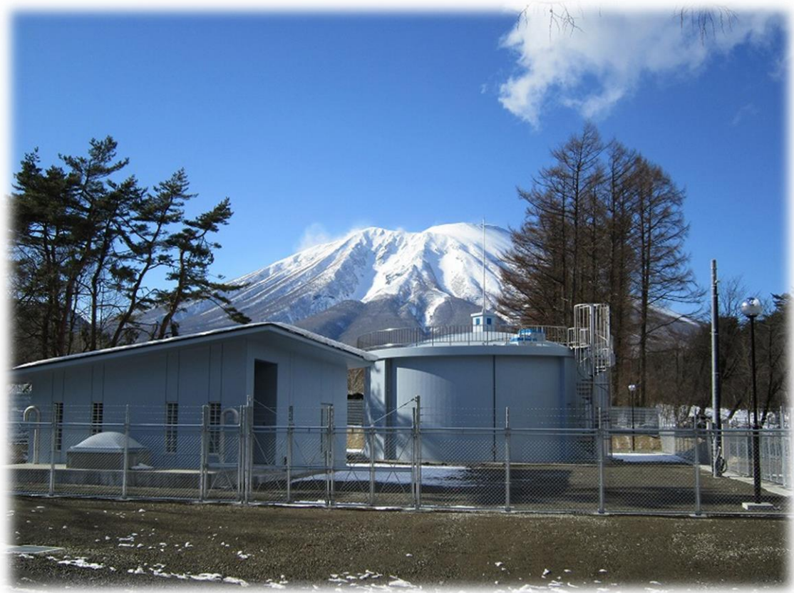
【岩手山浄水場】
