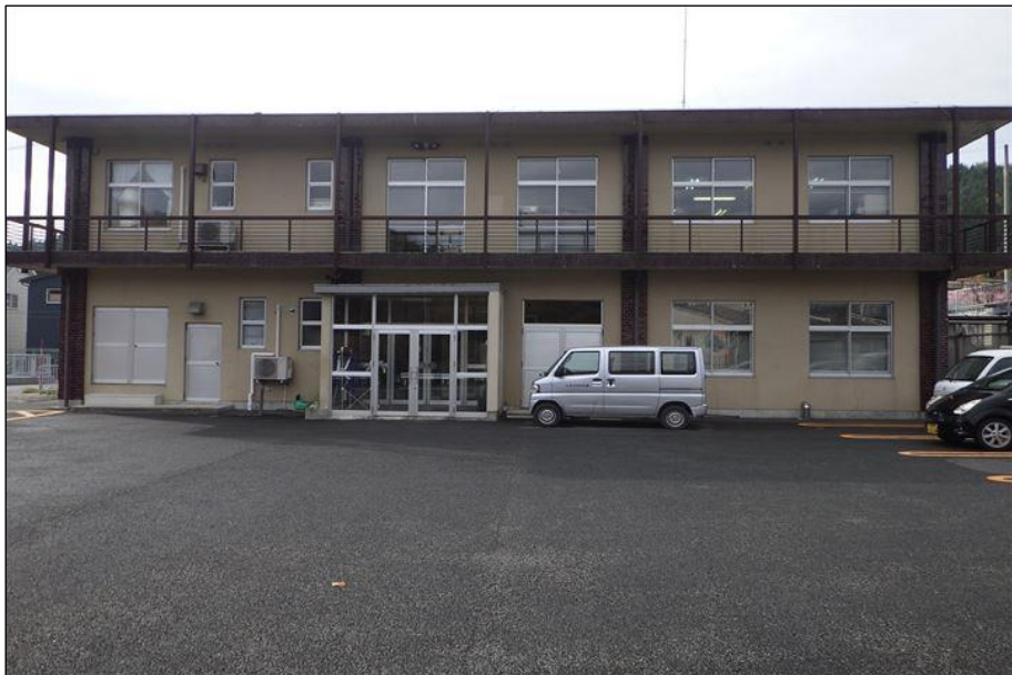
滝沢浄水場 管理棟
