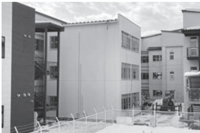
増築中の校舎（中央の建物）
