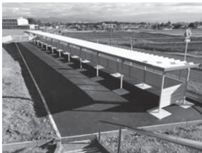
増設した駐輪場
