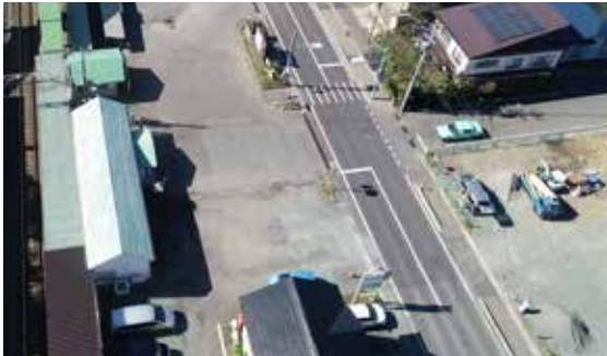
◀整備前の JR 小岩井駅前広場
