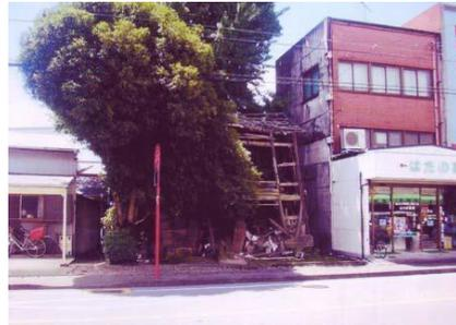
図 29:建築物や立木が近隣や道路に著しく傾斜し、放置されている状態
