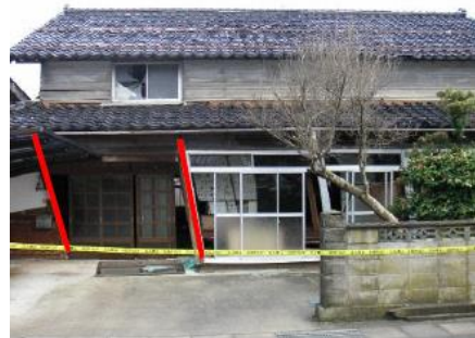
図 26：一階部分が傾斜し倒壊等のおそれがある状態
