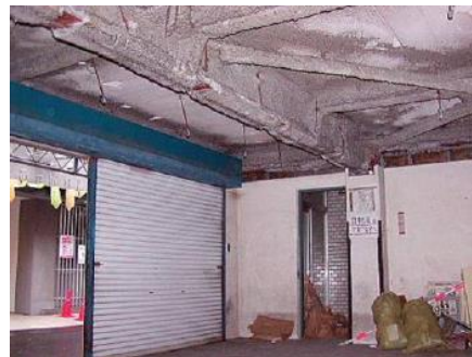
図 27：吹付け石綿等が飛散し暴露する可能性が高く衛生上有害となる状態
