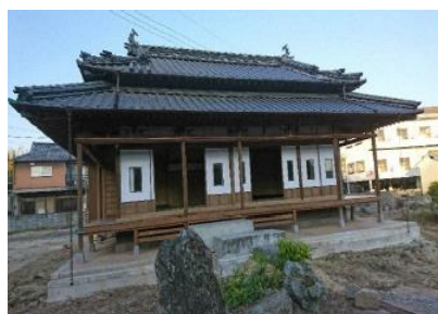
図 43:旧野上家 整備後(外観)
