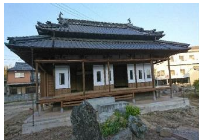
図 43:旧野上家 整備後(外観)
