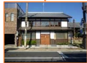
図 33:空き家の活用例 地域活性化のため、空き家を活用し観光 交流施設を整備
