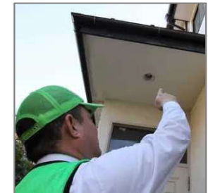
見回り時の目視点検の様子
