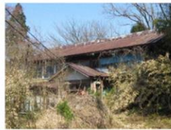
解体・ 除却前 ※住宅と して使用 しなくな り、約10 年が経過
