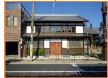
図 34:空き家の活用例 地域活性化のため、空き家を活用し観光交流施設を整備
