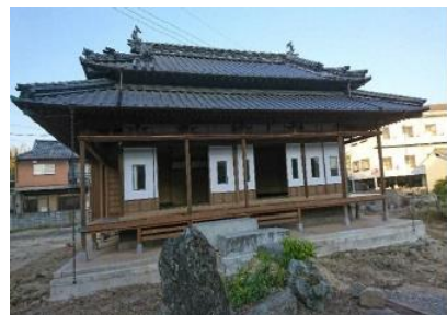
図 43:旧野上家 整備後(外観)
