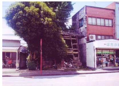
図 29:建築物や立木が近隣や道路に著しく傾斜し、放置されている状態
