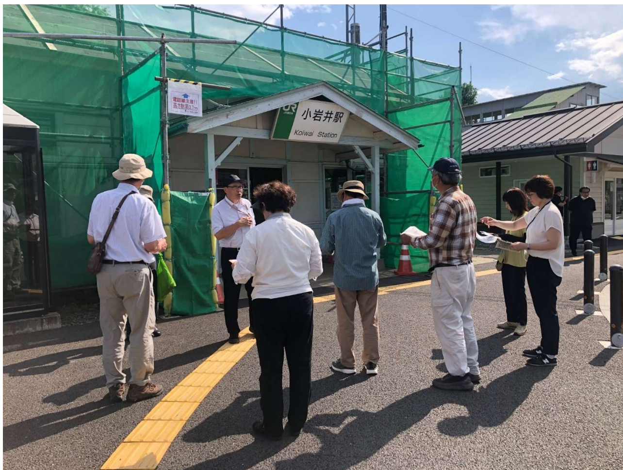
令和5年度第1回会議 現地確認：小岩井駅舎
