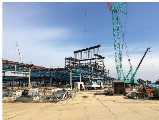
鉄骨立て方の様子（舞台プロセニウム上部の大スパン鉄骨、約19m×6mもの大きさ）
