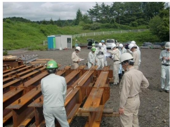
鉄骨工場での検査の様子
