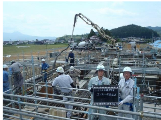
現場での基礎工事の様子
