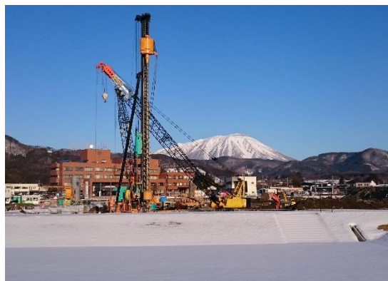
杭工事の様子
