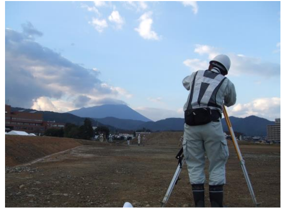
地縄張り作業の様子
